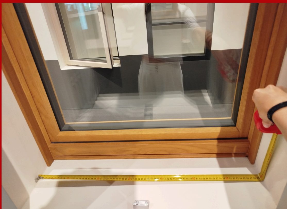
Esempio di rilievo misura architettonica della LARGHEZZA
